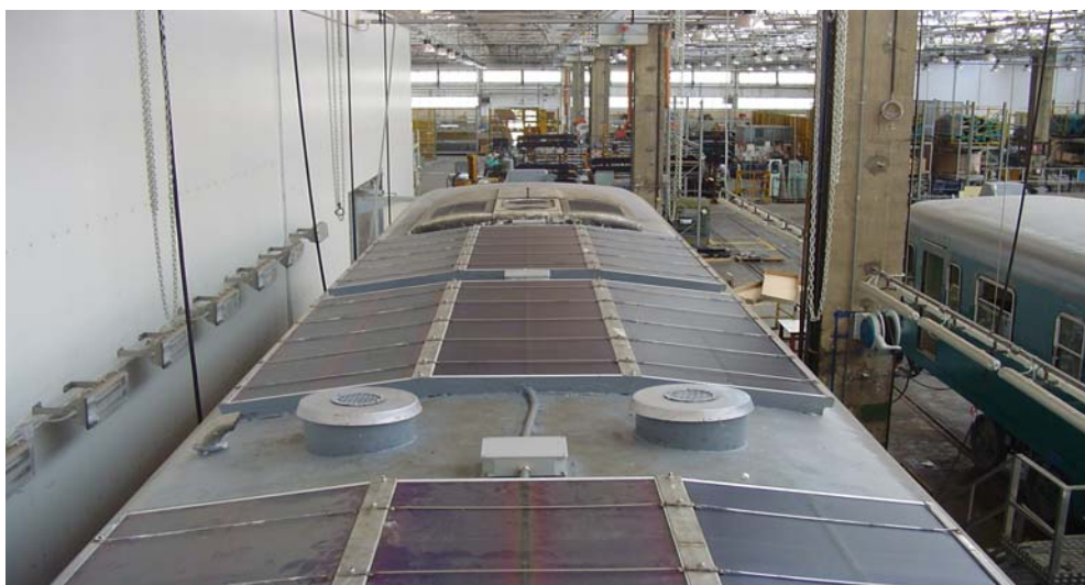
Applicazione dei moduli fotovoltaici US 116 sul locomotore diesel Aln 668
