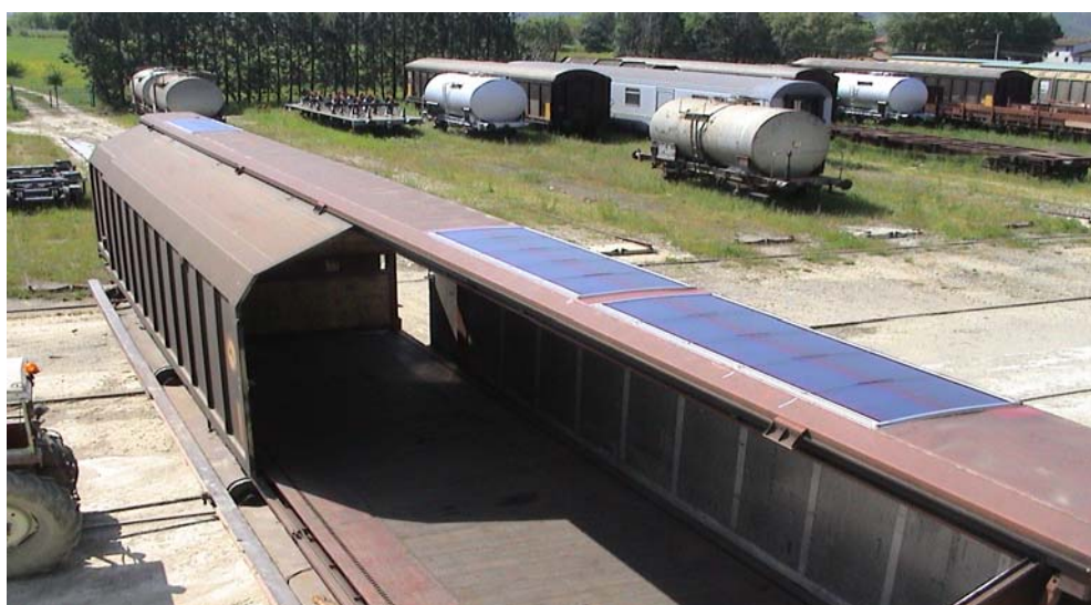
Applicazione dei moduli fotovoltaici US 116 sul carro merci
